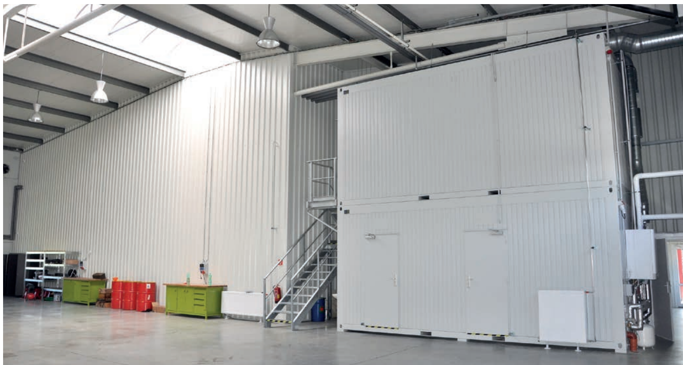
Interiér haly – dělicí příčka z trapézového plechu vč. kancelářské techniky
