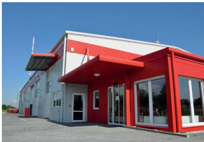
Zastřešení vstupů pomocí přístřešků
