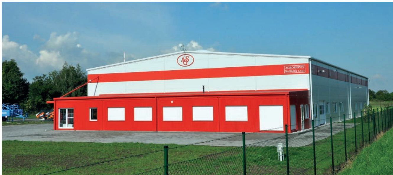
Servisní hala Agroservis Sedláček s.r.o.
