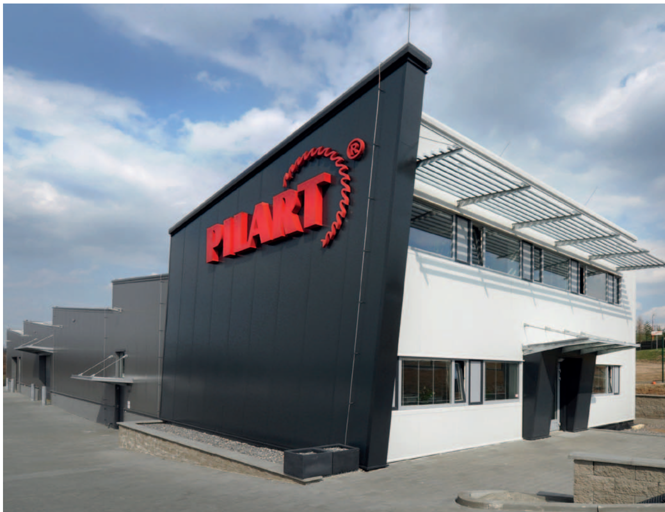
Montovaná administrativní a prodejní hala Pilart
