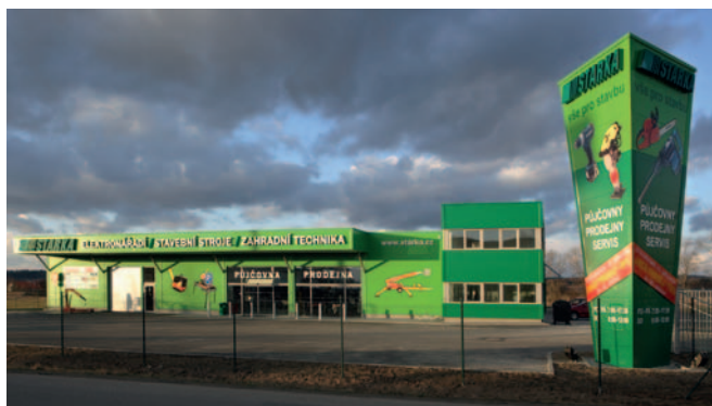
Montovaná hala Starka České Budějovice
