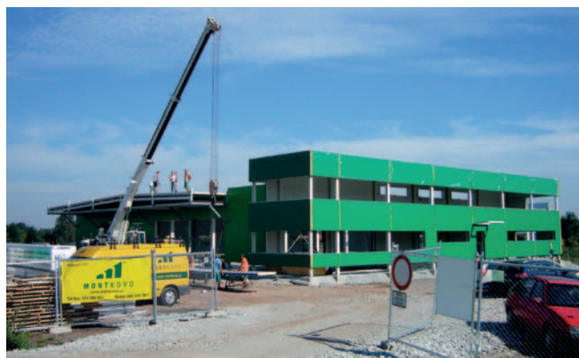
Montáž opláštění
